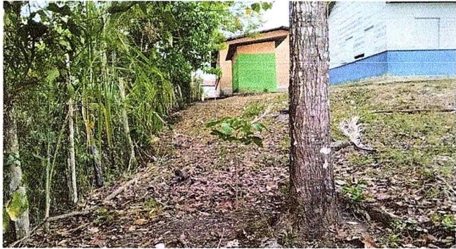
Foto 1: DE ESTA MANERA SE ENCONTRABA EL PREDIO DEL ESTABLECIMIENTO, CON MALLAS Y POSTES DETERIORADAS
