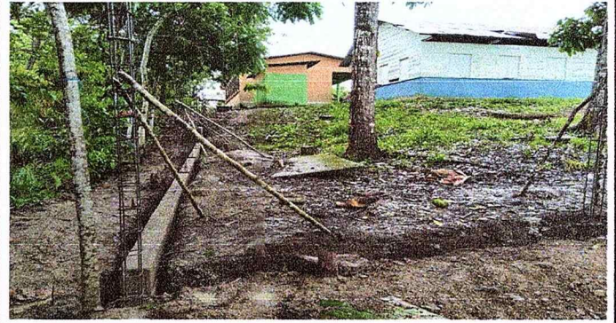
Foto 2: INICIO DE LABORES DEL CIERRE DEL PREDIO (CERCO O MURO PERIMETRAL)
